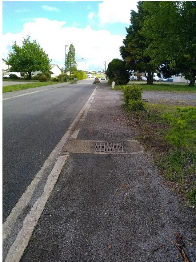
Collecte des eaux pluviales par 2 réseaux en bord de voies, caniveau et grilles décalées. Réseau sous trottoir à faible profondeur (< 1m)
